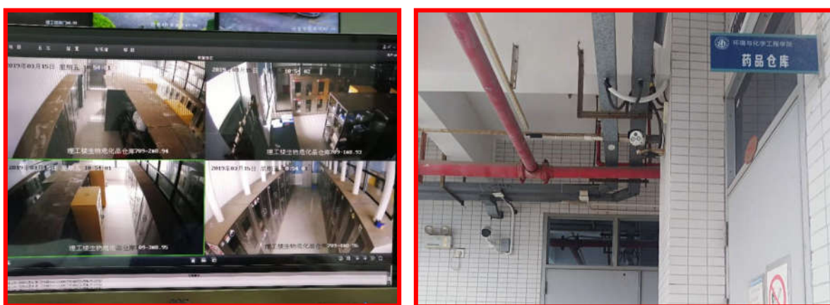
图 1 全方位监控（左图为保卫处监控中心监控理工楼 709 仓库内部画面； 右侧为理工楼 709 仓库外部部高清监控摄像枪
